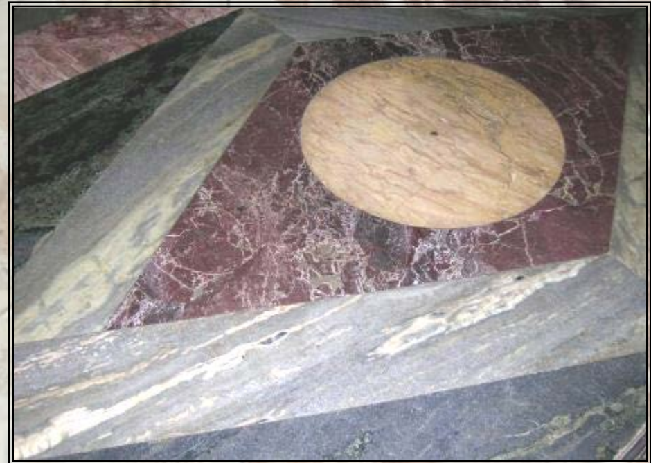
Particolare della pavimentazione
